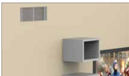
Sia la climatizzazione idronica che l'immissione della ventilazione meccanica controllata possono confluire in un'unica bocchetta, che potrà fornire sia climatizzazione che ricambio aria all'ambiente, con un positivo impatto estetico ed architettonico.
